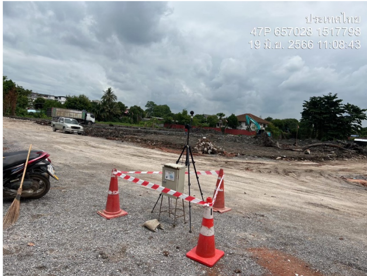
บริษัท ทีเอ็นพี เอ็นไวรอนเม้นท์ จำกัด เข้าติดตั้งเครื่องตรวจวัดความสั่นสะเทือน
